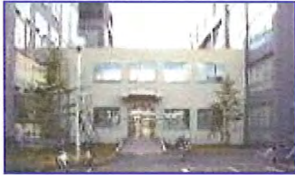
② 渡り廊下からの出入口
